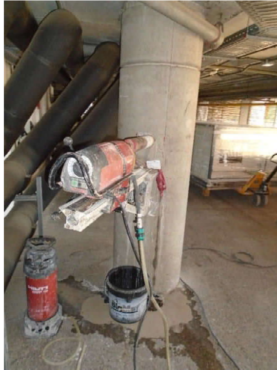
Foto 33. Vista extracción de testigo en pilar 84 en planta técnica (entresuelo)
